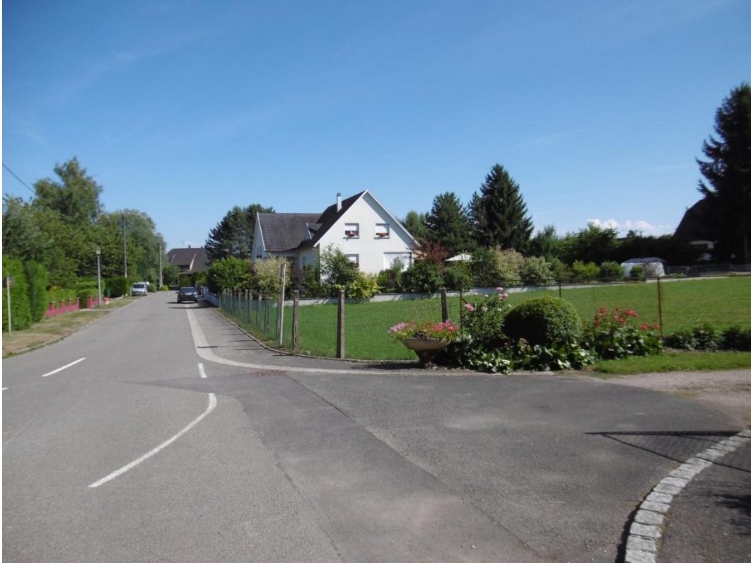
En zone urbanisée calme (rue de Traubach)
