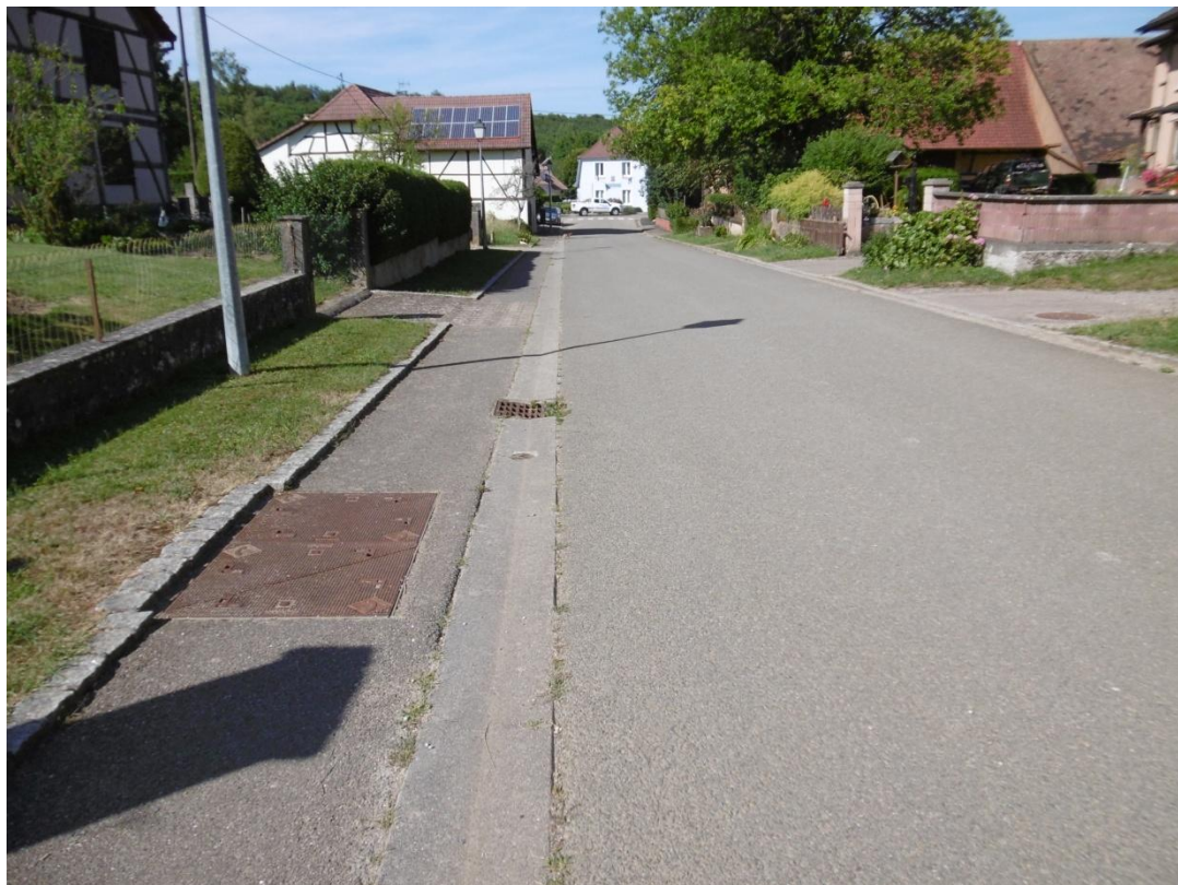
Caniveau et déversoir eaux pluviales dans le réseau sous chaussées rue de Valdieu
